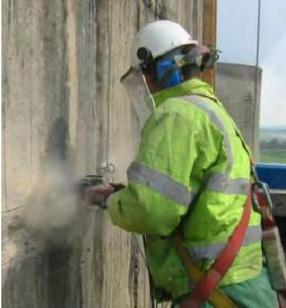
Fosroc ofrece una extensa gama de productos para la reparación del hormigón conformes a la norma europea y al mercado CE, entre los que se incluyen nuestros morteros de reparación Renderoc.
