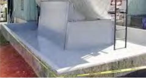
Con el fin de evitar el deterioro del terreno o el subsuelo en el caso de vertidos durante la producción o el almacenamiento, es habitual disponer de cubetos de retención que requieren de una protección especial.
