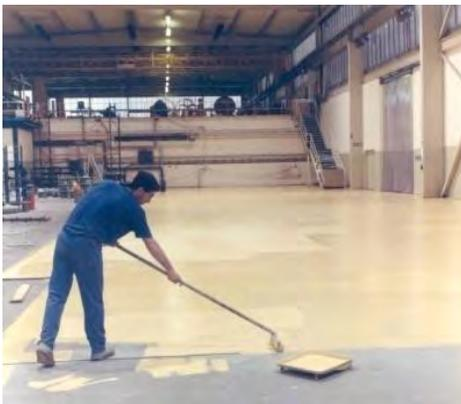
Nitoflor FC130 es un revestimiento epoxi base agua que proporciona una superficie antipolvo y de fácil limpieza.
